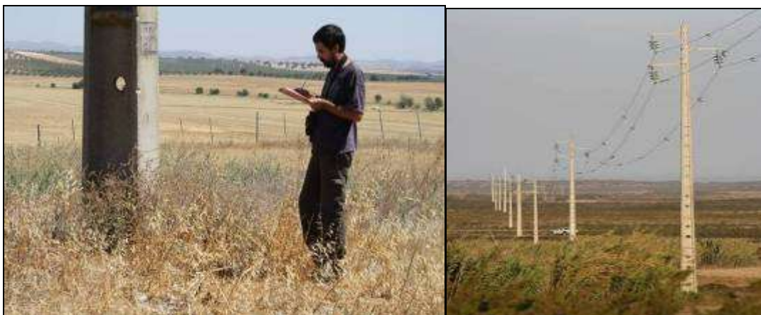
Fotografia 4 e 5 – Avaliação do tempo de vida útil dos materiais anti-electrocussão em Campo Maior e linha corrigida com dispositivos anti - colisão (Fireflies tipo fitas) na ZPE SE Alentejano Costa Vicentina
