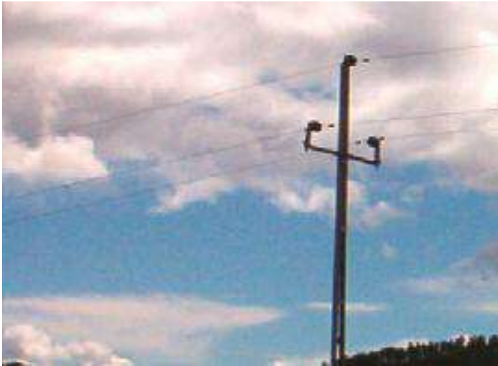
Apoio em triangulo com isoladores rígidos
