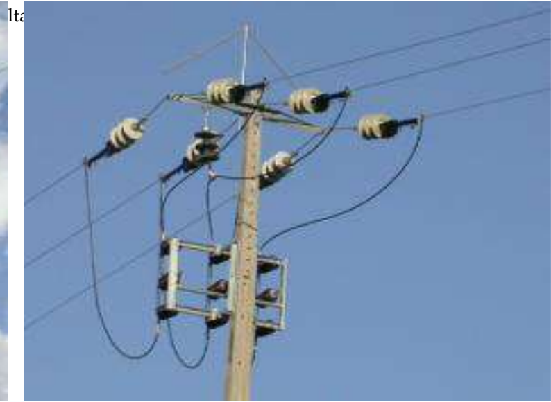
Fotos: 18 e 19 - Em cima linha na ZPE do PNTI corrigida no decorrer do estudo. Foram aplicadas medidas anti colisão e electrocussão, nomeadamente isolamento dos arcos e pinças, passagem de seccionador horizontal para vertical, colocação de dispositivos anti poiso e BFD.
