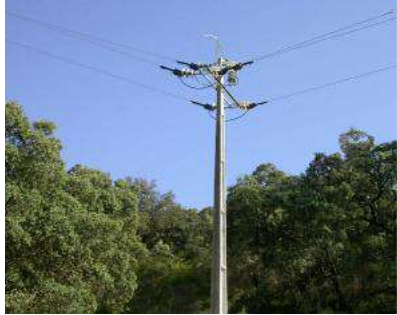
Fotos: 20,21 e 22 - Em cima à esquerda BFV usado nas correcções anti colisão, em cima a direita apoio com medidas de correcção e em baixo pormenor do isolamento no mesmo apoio.
