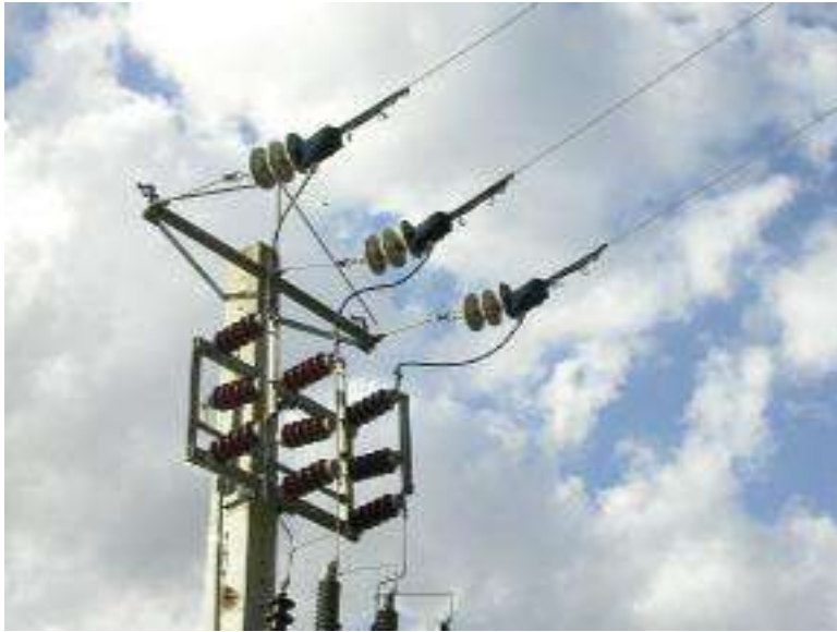
Fotos: 18 e 19 - Em cima linha na ZPE do PNTI corrigida no decorrer do estudo. Foram aplicadas medidas anti colisão e electrocussão, nomeadamente isolamento dos arcos e pinças, passagem de seccionador horizontal para vertical, colocação de dispositivos anti poiso e BFD.
