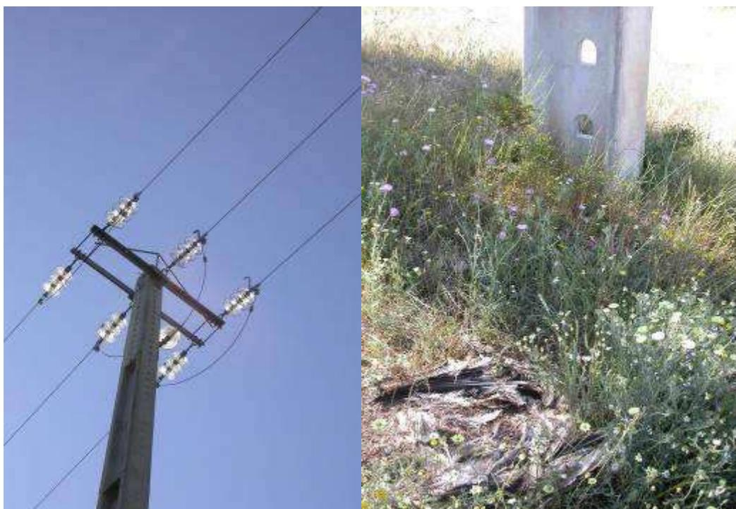
Imagem 7 – Apoio tipo HRFSC no PNSSM onde ocorreu electrocussão de um Grifo.
