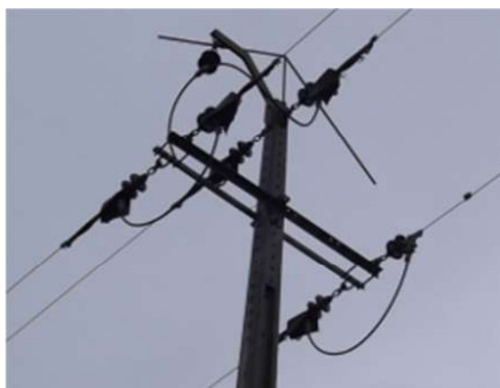
Fotografia 8 – Linha Quinta da N.º Sr.ª do Espinheiro em que se detetou que não existe protetor de pinça de amarração, no âmbito da avaliação do tempo de vida útil dos equipamentos anti-eletrocussão.
