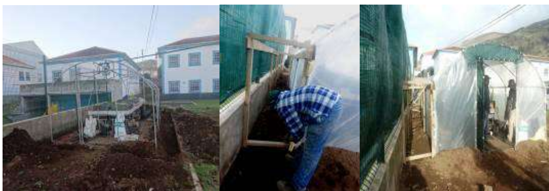
Figura 27_ Reparação e reforço do Estufim
