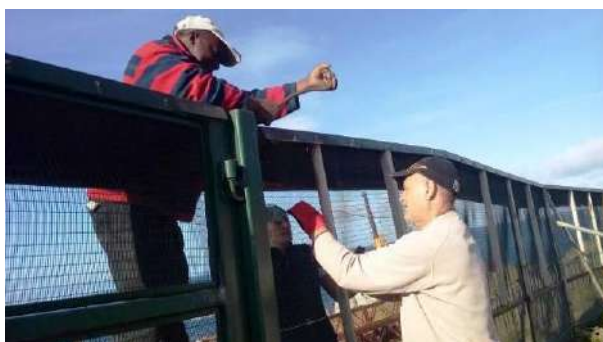
Figura_4 Reparação do portão da RBC
