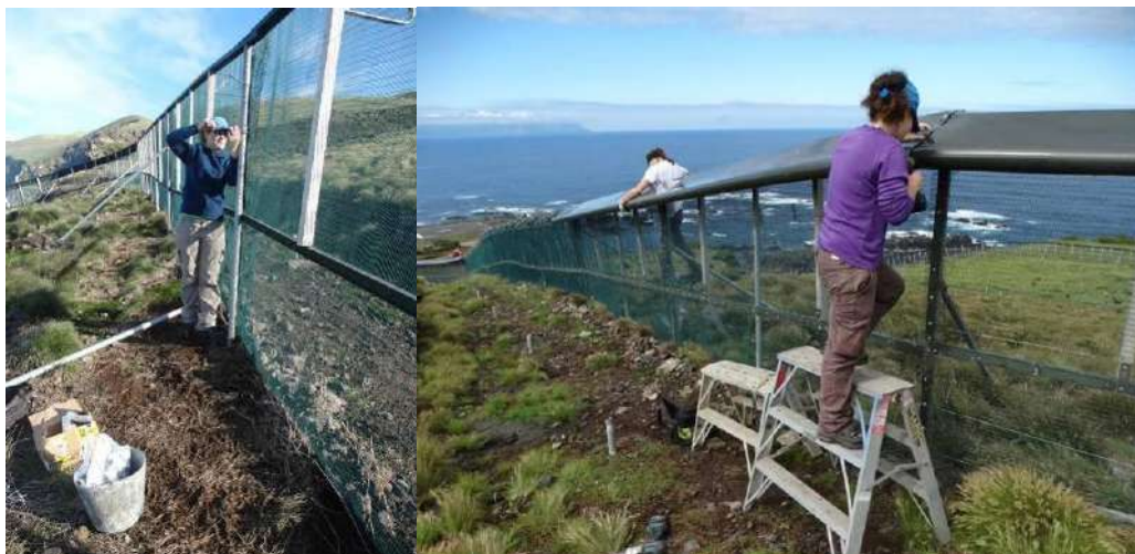
Figura_3 Colocação de tubos de suporte interiores após colocação da rede (direita) e colocação das chapas que previnem a entrada de gatos e roedores (esquerda).
