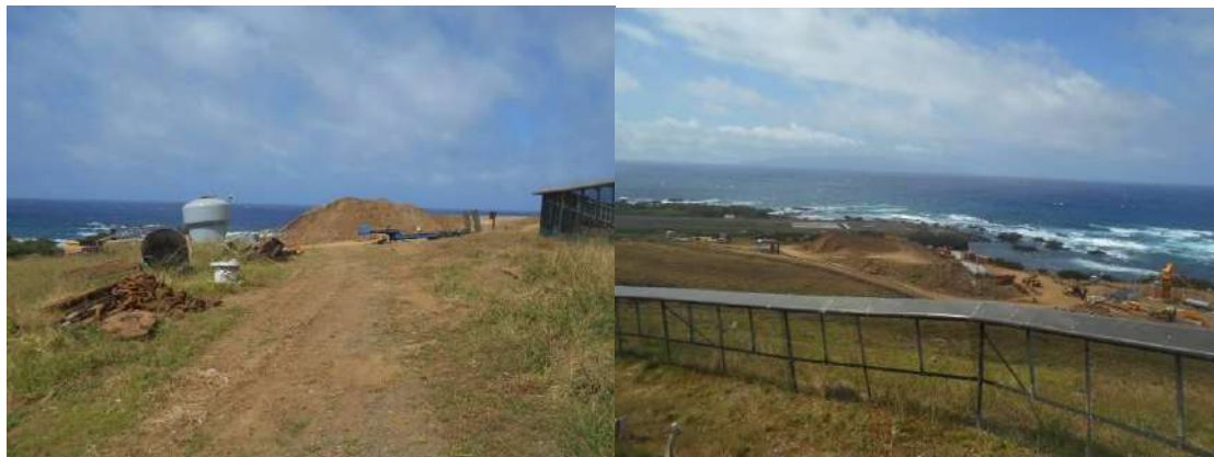
Figura_20 Estaleiro para as obras de extensão do Porto da Casa colocado em frente à RBC
