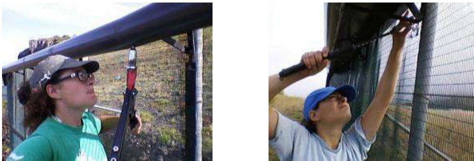
Figura 1_ Manutenção da vedação antipredadores. Reparação da rede (à esquerda) e substituição de rebite que une gancho de suporte e chapa (direita).
