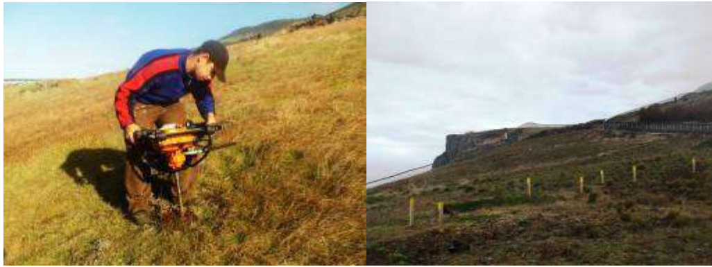
Figura 19_ Construção do percurso interpretativo no interior da RBC
