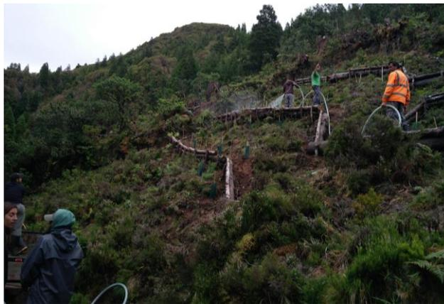
Figura 5\_ Aplicação de hidrosementeira nas derrocadas do Pico da Serreta em 2019
